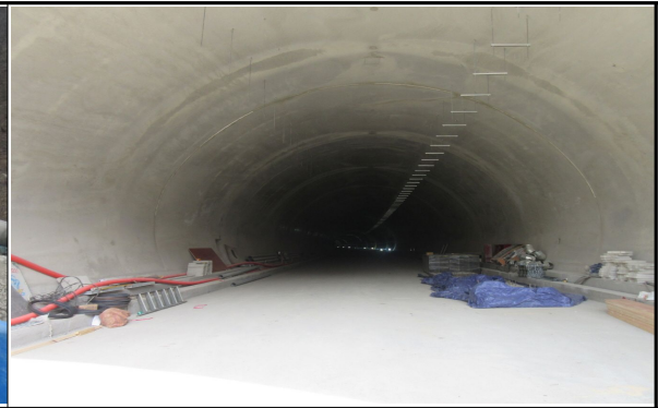
지정3터널 내부 전경(서울방향)
