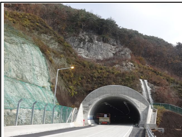
갱문 시점부 전경
