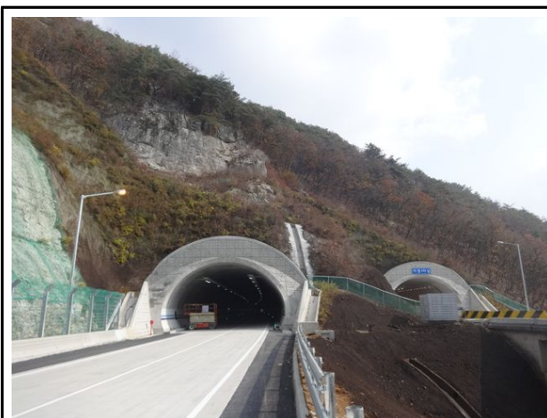
시점측 터널부사면 전경
