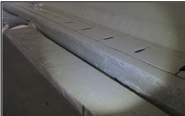
지정3터널 공동구 시공 상태 점검(서울방향)
