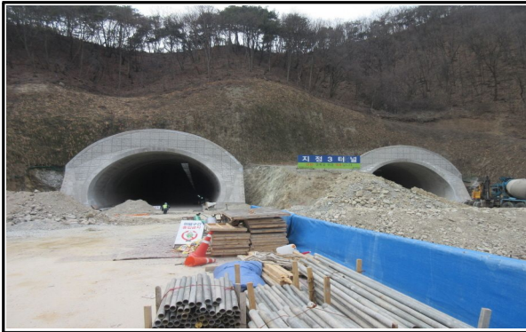
지정3터널 시공 전경
