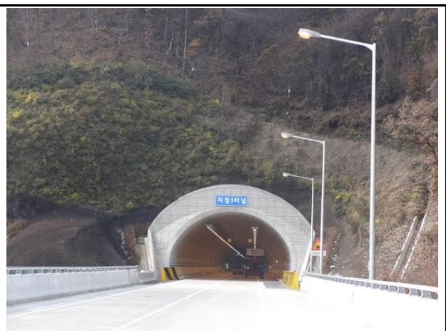
갱문 종점부 전경
