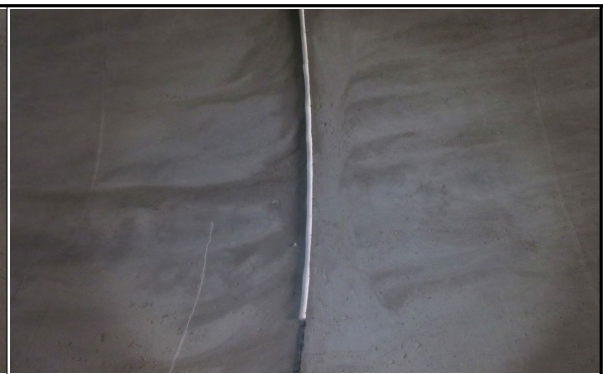
지정3터널 JOINT 시공 상태 점검(서울방향)
