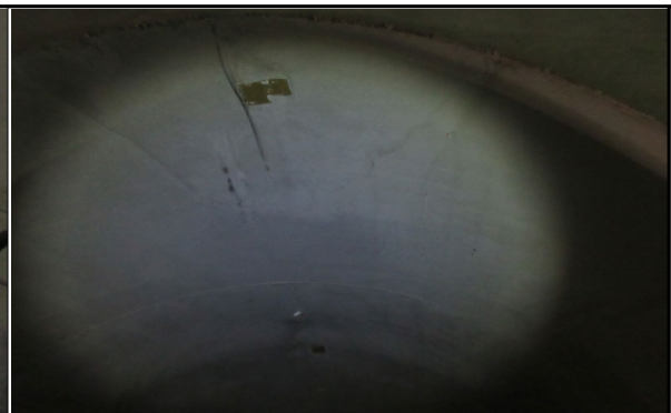
지정3터널 라이닝 천정부 시공 상태 점검(서울방향)
