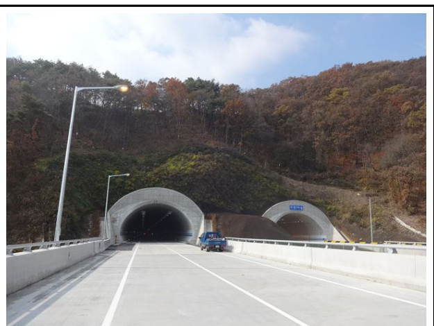
종점측 터널부사면 전경
