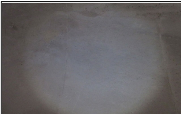
지정3터널 라이닝 시공 상태 점검(서울방향)
